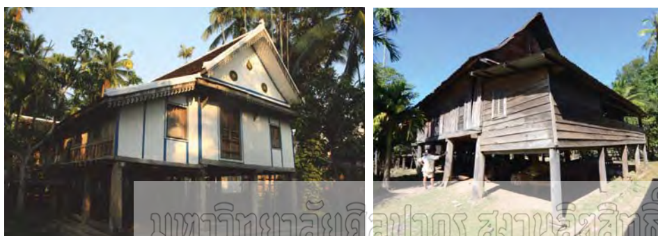
ภาพที่ 5: (ซ้าย) เรือนชาวลาวลุ่มที่หลวงพระบาง (ขวา) เรือนชาวลาวลุ่มที่จำปาสัก ต่างก็เป็นเรือนที่ ตั่งเสาไม้ที่ตั่งบนดินเสาทิน ที่มา: เกรียงไกร เกิดศิริ
