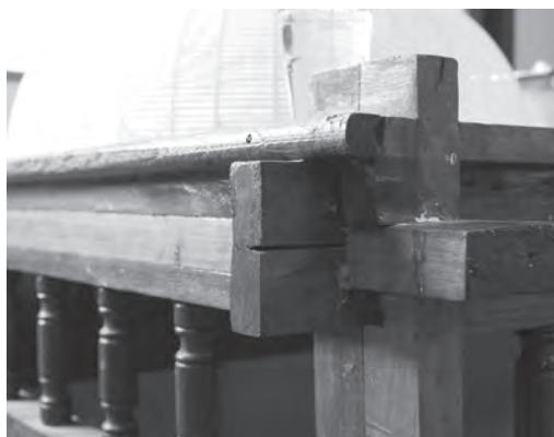
ภาพที่ 7: ข้อต่อเถรอดเพลของโต๊ะใช้ไม้จริงหน้าตัดรูป สี่เหลี่ยมผืนผ้า
